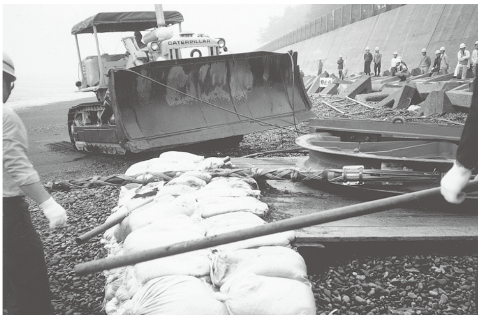
海底ケーブル陸揚げ作業 Landing work of a submarine cable.
