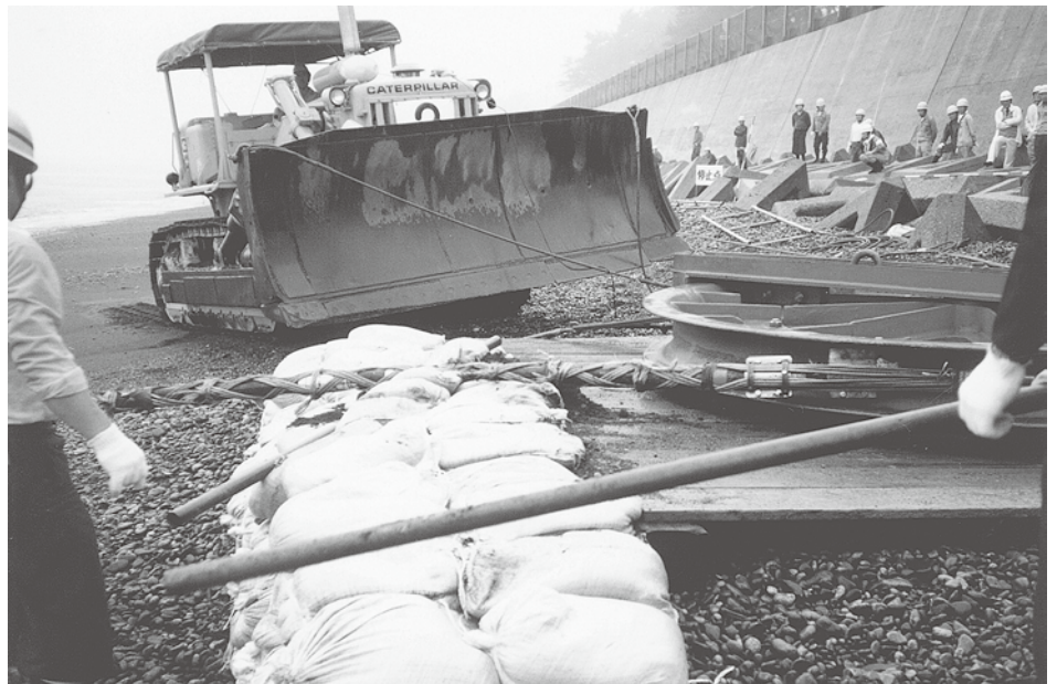
海底ケーブル陸揚げ作業 Landing work of a submarine cable.
